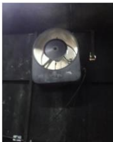
Figuras 22 e 23: Vista do interior do compartimento enclausurado. A empresa foi orientada a ligar imediatamente o exaustor, visto que havia grande quantidade de poeira de carvão, além de o ambiente estar muito quente.
